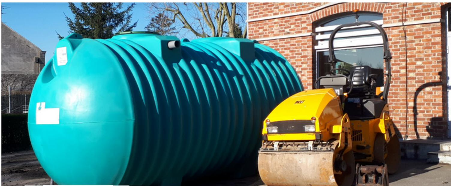
La commune a favorisé depuis de nombreuses années la préservation de la ressource en eau, et ce par différents biais : d'abord avec l'installation de cuves enterrées : une cuve de 10m<sup>3</sup> sous le parking de la salle des sports et une cuve de 20m<sup>3</sup> sous le bâtiment des services techniques pour une utilisation interne liée aux besoins du service. Ensuite, des cuves « réserves » d'1 m<sup>3</sup> ont été placées à des
